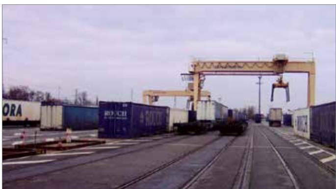
Le chantier de transport combiné Naviland Cargo / photo: SYSTRA et la plate-forme ferroviaire (ex-Novatrans) / photo: SYSTRA
