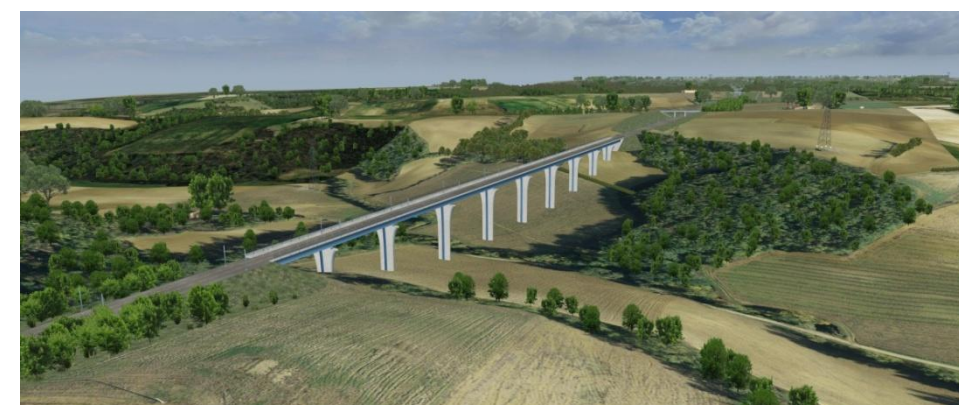
Viaduc sur la commune de Donzac (Tarn-et-Garonne)
